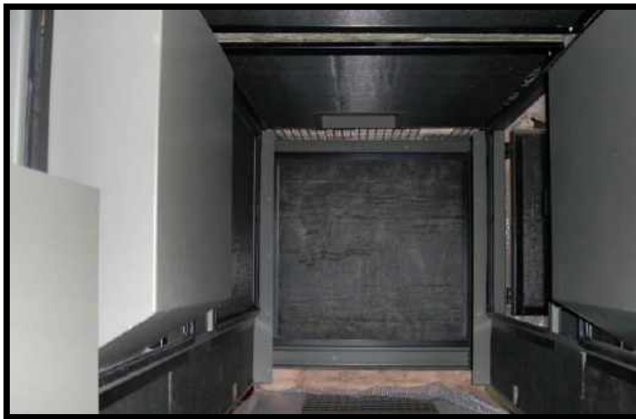
Imagen 5- Interior de un Grupo Electrónico insonorizado
