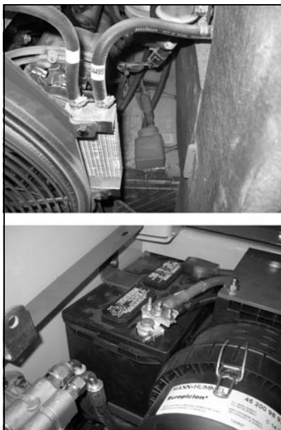
Figura 55 – Ubicaciones de la batería
