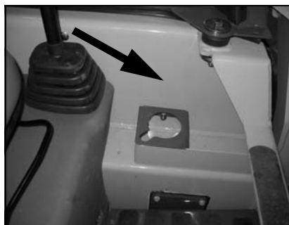
Figura 1 – Ubicación del extintor de incendios
